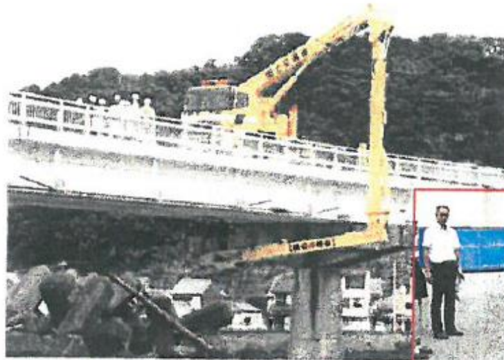
← 橋梁点検車を用いた橋脚検査
