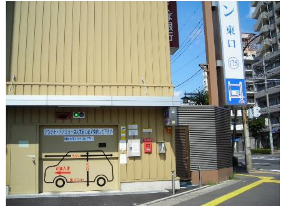
ホテル立体駐車場
